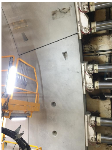
Rys. 4. Tłoki lewarów hydraulicznych oparte o wykonany pierścień obudowy tunelu [fot. autor].
