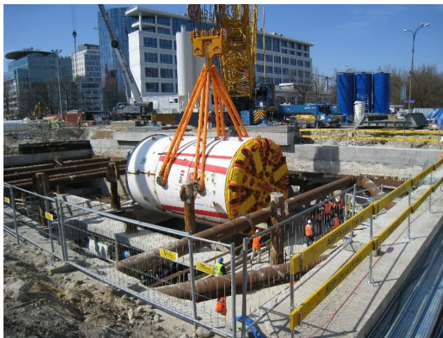
Rys. 7. Opuszczanie tarczy na dno komory startowej – metro warszawskie [fot. autor].
